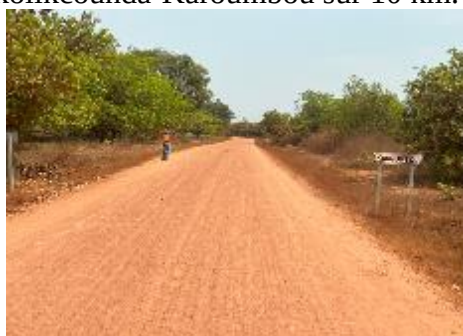
Photo 5 : Piste latéritique Mankolikounda-Karoumbou
