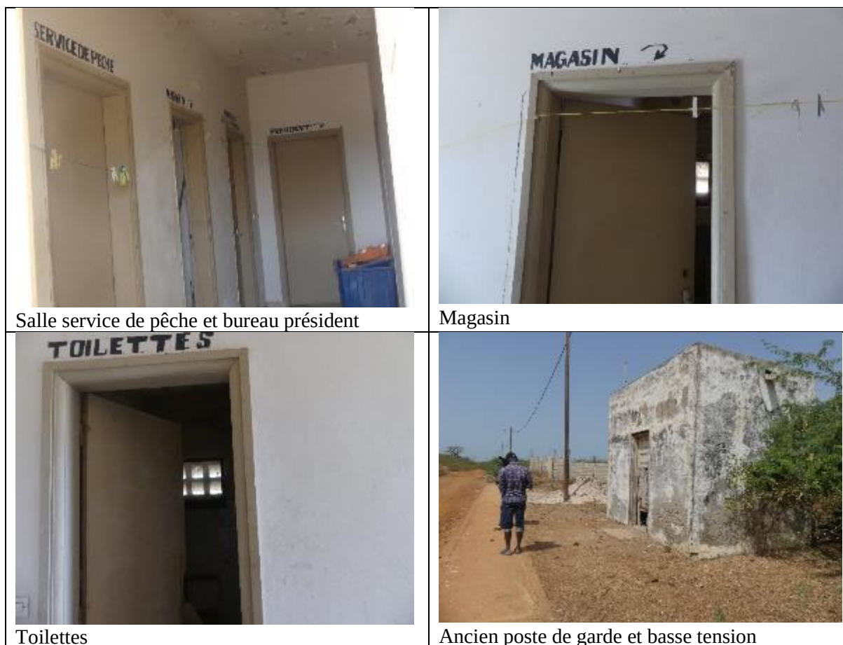
Photo 20 : Vue d'ensemble de l'environnement du site du bâtiment administratif du pôle aquacole de Diakhanor (Source : Hpr Ankh, janvier 2024)
