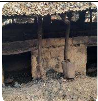
Vue des Fours en dehors du quai
