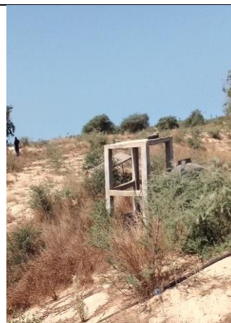
Photo 8 : Aménagement et Panneau solaire
