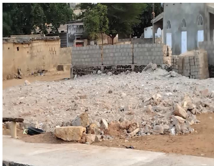
Figure 6 : Site affecté à la construction du poste de contrôlePhoto 2 :
