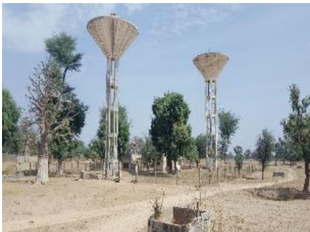
Photo 1 : Forage situé au Nord du site
