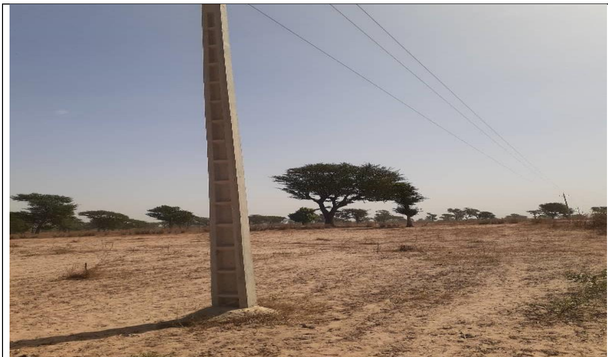
Photo 3: Présence d'une ligne électrique au Nord-Ouest du site projet
